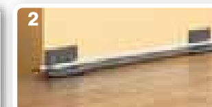
2. A vezetékek lefektetése
